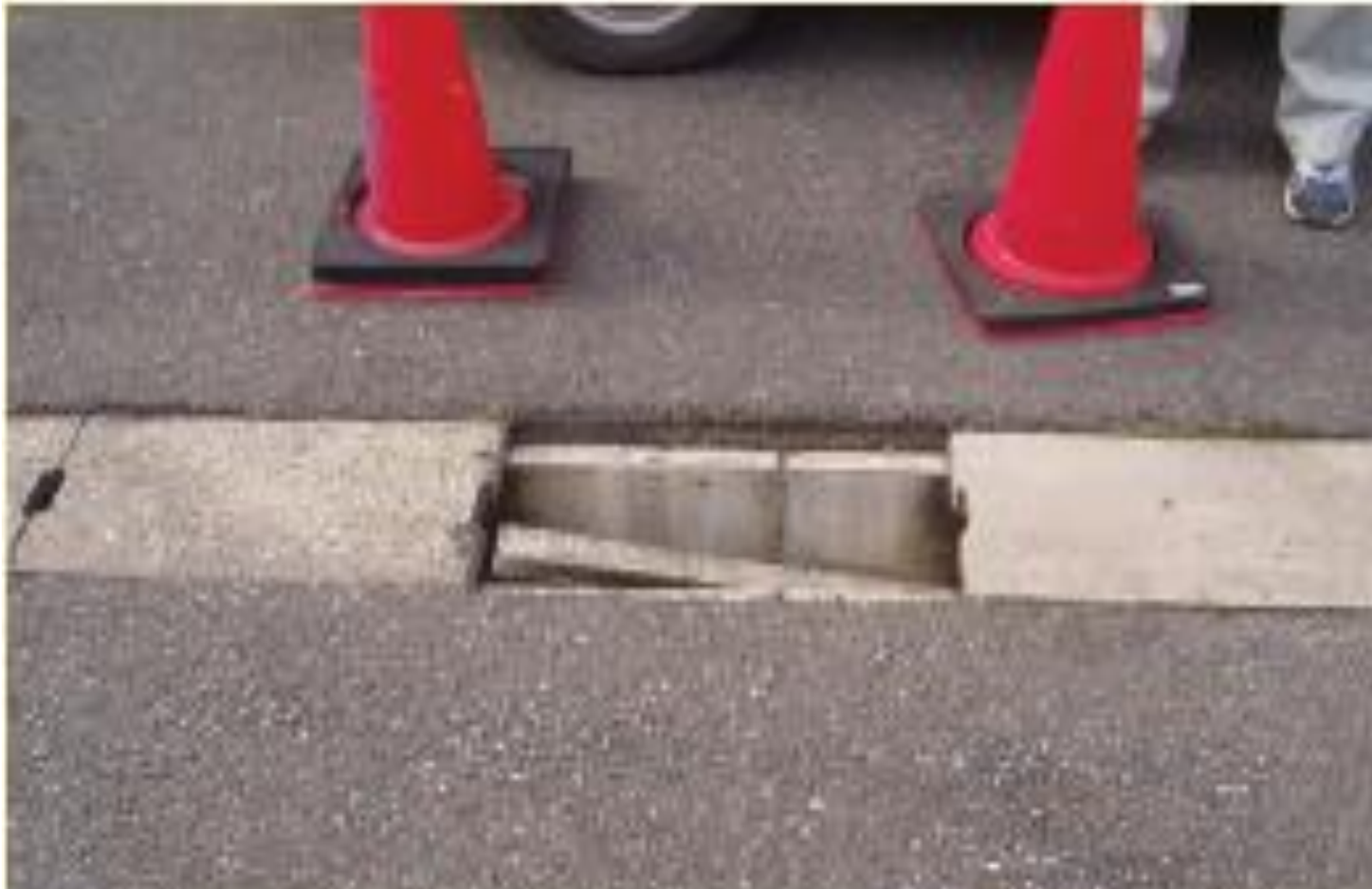
側溝・蓋の破損
