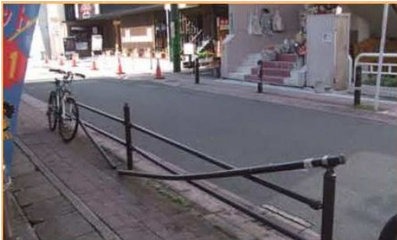
防護柵の破損
